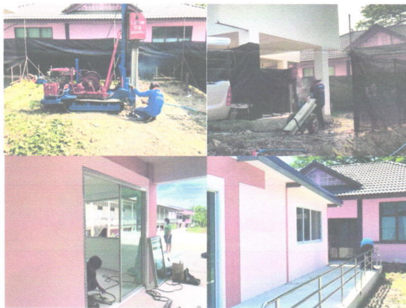
ภาพระหว่างก่อสร้างห้องกายภาพบำบัด
