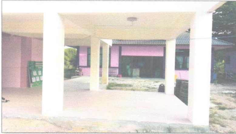
ภาพก่อนก่อสร้างห้องกายภาพบำบัด
