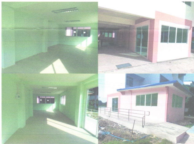
ภาพห้องกายภาพบำบัดที่ก่อสร้างเสร็จ (ยังขาดแคลน เครื่องปรับอากาศ ฝ้าม่าน และปรับภูมิทัศน์โดยรอบ)
